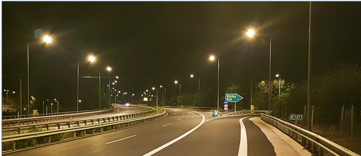
Εικόνα 5: Νέα φωτιστικά σώματα τύπου LED πλησίον του Α/Κ Νεοχωρίου (άποψη περί τη Χ.Θ. 137+100).
