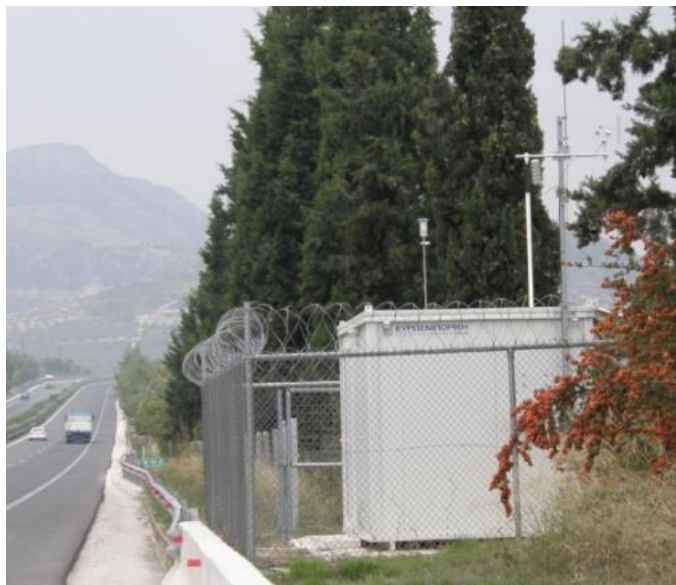
Εικόνα 4: Άποψη του ΜΣΜ Σολομού Κορινθίας (Χ.Θ. 90+930).
