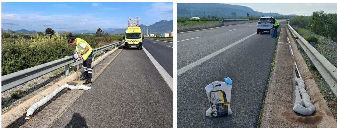
Εικόνα 3: Φωτογραφίες από την Άσκηση Περιβαλλοντικής Ετοιμότητας 2025. Διακρίνονται τα απορροφητικά φράγματα ανάσχεσης ρύπων και η απορροφητική άμμος.
