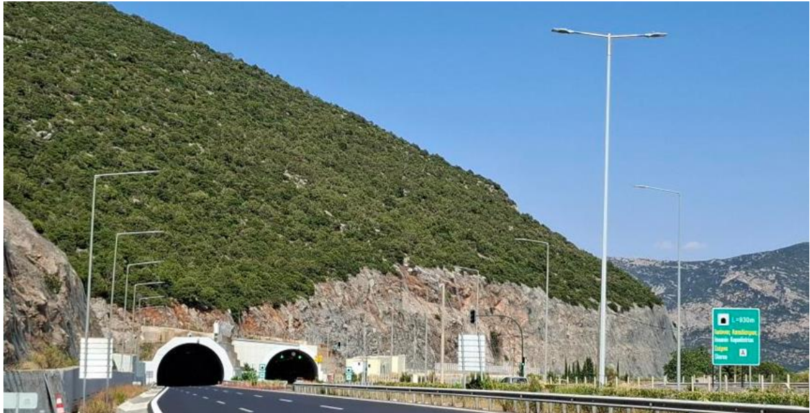
Εικόνα 5: Νέα φωτιστικά σώματα τύπου LED πλησίον της σήραγγας «Ιωάννης Καποδίστριας» (άποψη περί τη Χ.Θ. 133+200).
