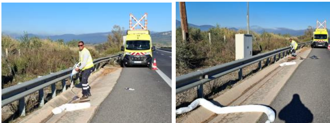
Εικόνα 3: Φωτογραφίες από την Άσκηση Περιβαλλοντικής Ετοιμότητας 2024. Διακρίνονται τα απορροφητικά φράγματα ανάσχεσης ρύπων και η απορροφητική άμμος.
