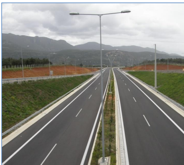
Εικόνα 1: Άποψη των φυτεύσεων της κεντρικής νησίδας και των ερεισμάτων του αυτοκινητόδρομου.
