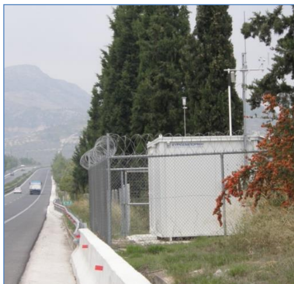
Εικόνα 4: Άποψη του ΜΣΜ Σολομού Κορινθίας.
