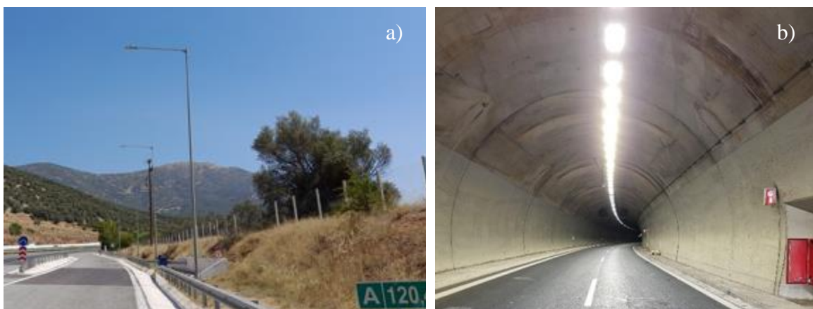
Εικόνα 5: Φωτιστικά σώματα νέας τεχνολογίας, τύπου LED, a) σε χώρο στάθμευσης (parking) και, b) στη σήραγγα Νεοχωρίου.
