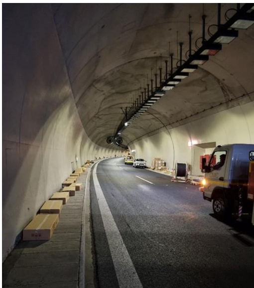
Εικόνα 6: Ενεργειακή αναβάθμιση της σήραγγας Νεοχωρίου (Φιλελλήνων – Χ.Θ. 135) με νέα φωτιστικά σώματα τύπου LED.
