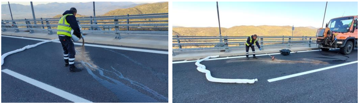
Εικόνα 3: Φωτογραφίες από την Άσκηση Περιβαλλοντικής Ετοιμότητας 2022. Διακρίνονται τα απορροφητικά φράγματα ανάσχεσης ρύπων και η απορροφητική άμμος.
