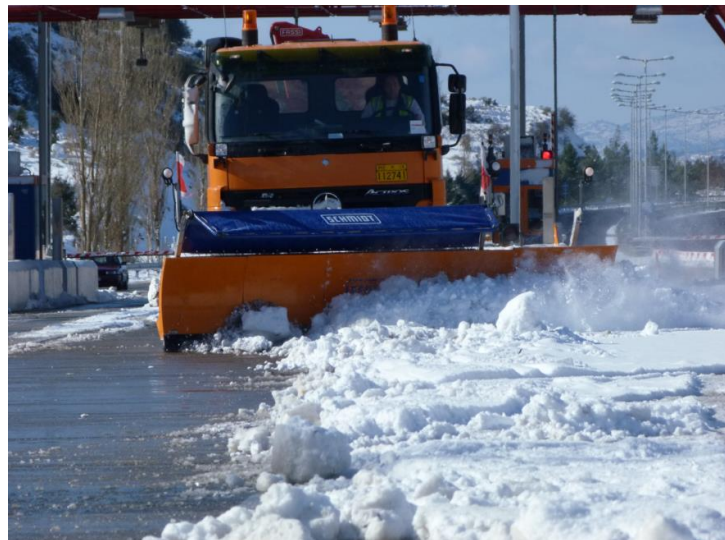
Εικόνα 2: Εργασίες εκχιονισμού σε εξέλιξη.
