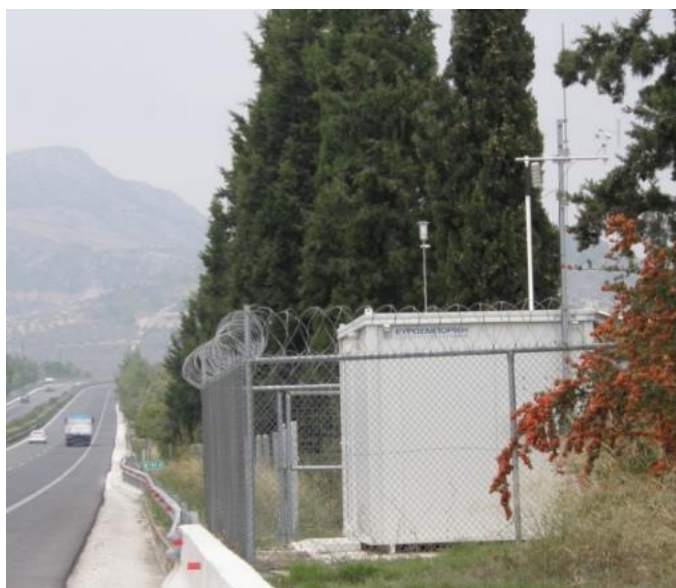
Εικόνα 5: Άποψη του ΜΣΜ Σολομού Κορινθίας (Χ.Θ. 90+930).
