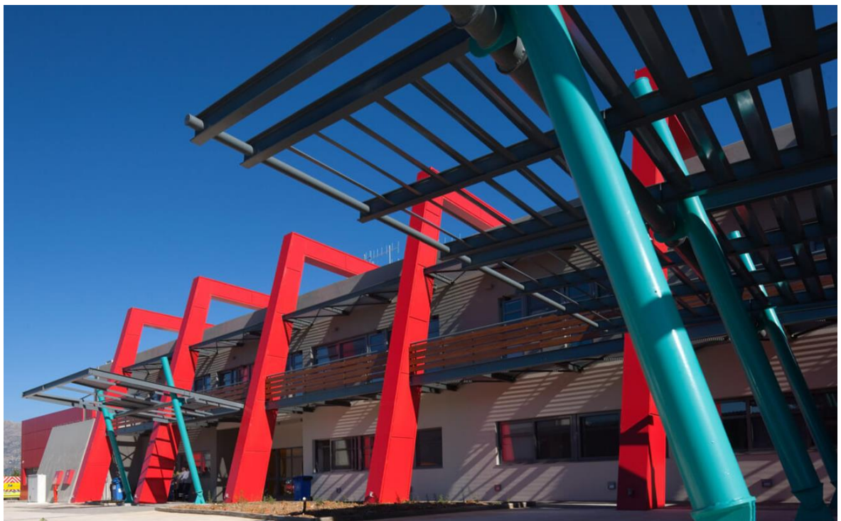
Εικόνα 1: Άποψη του Κέντρου Ελέγχου και Συντήρησης (ΚΕΣ) της ΜΟΡΕΑΣ Α.Ε. στη Νεσπάνη Αρκαδίας (Χ.Θ. 149+400).
